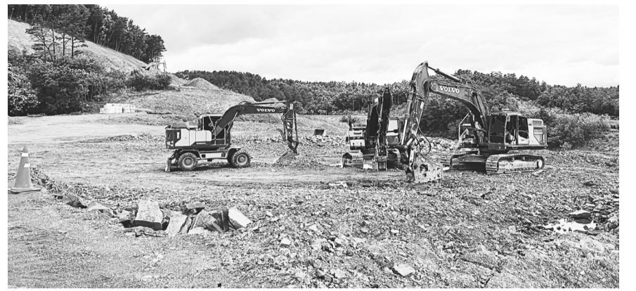
중장비 뒷쪽이 야사지구토지구획정리사업 영천시 동부동주민복지센터 신축 이전 및 국민체육진흥센터 조성 부지
